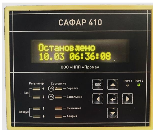
Рисунок 2.11 – Экран при включении горелки
