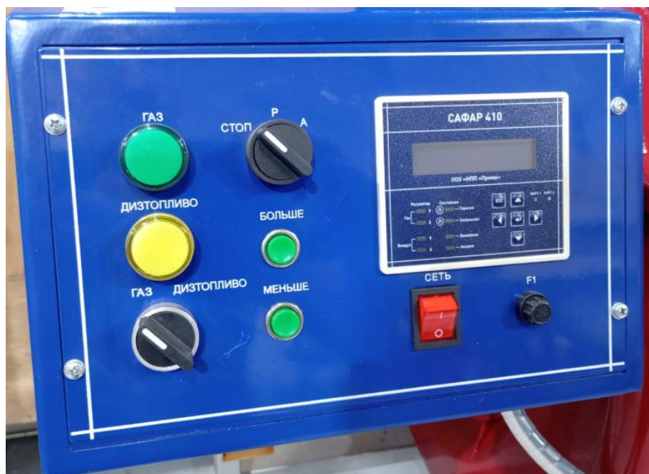
Рисунок 1.6 - Внешний вид блока управления - лицевая панель.
