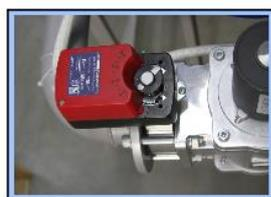
Электропривод DM-04-230 газовой заслонкой
